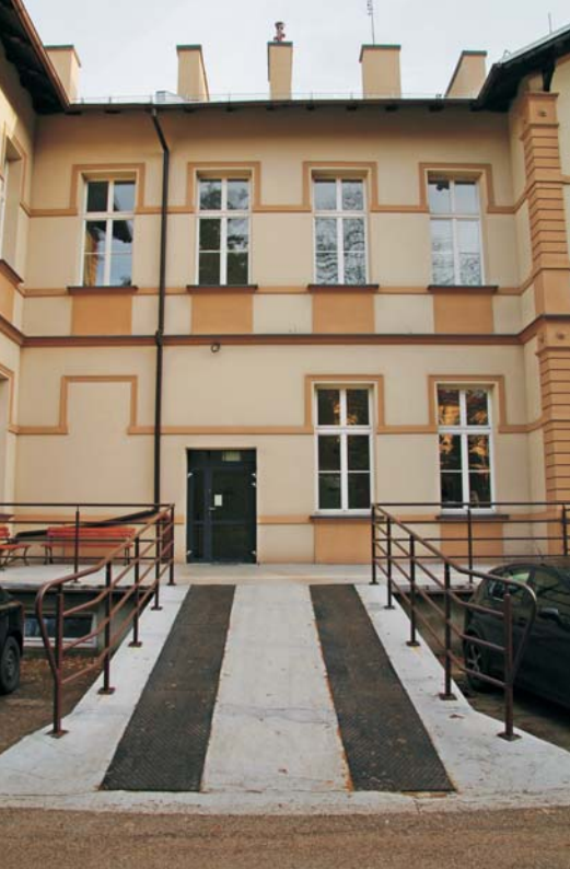
Przeprowadzono konserwację dachu Pawilonu I i wyremontowano podjazd
