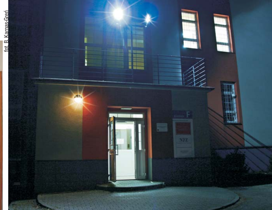
Przed Pawilonem VII zostało zainstalowane nowe oświetlenie
