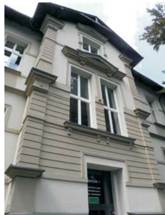
Odnowiony zabytkowy portal nad wejściem głównym
