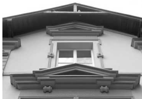
Odtworzone detale architektoniczne
