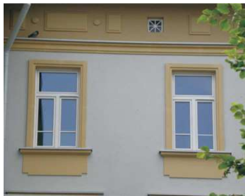
Odtworzone detale architektoniczne
