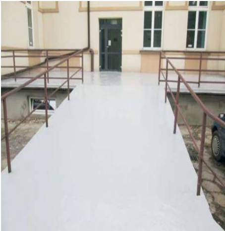
Wyremontowano podjazd do Oddziału Nefrologicznego
