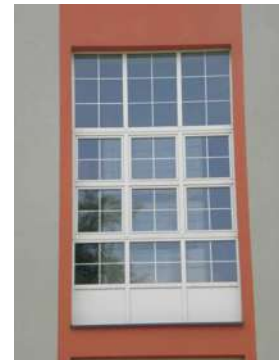
Okno klatki schodowej
