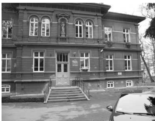
Budynek po termomodernizacji
