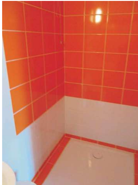
Wyremontowano ponad 40 łazienek
