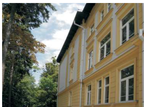
Budynek po termomodernizacji - elewacja od strony zachodniej
