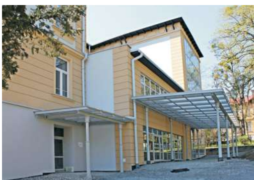
Budynek po termomodernizacji z dobudowaną częścią
