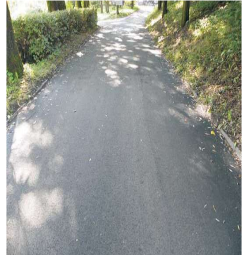
Położono 840 m 2 nowej nawierzchni dróg na terenie parku szpitalnego
