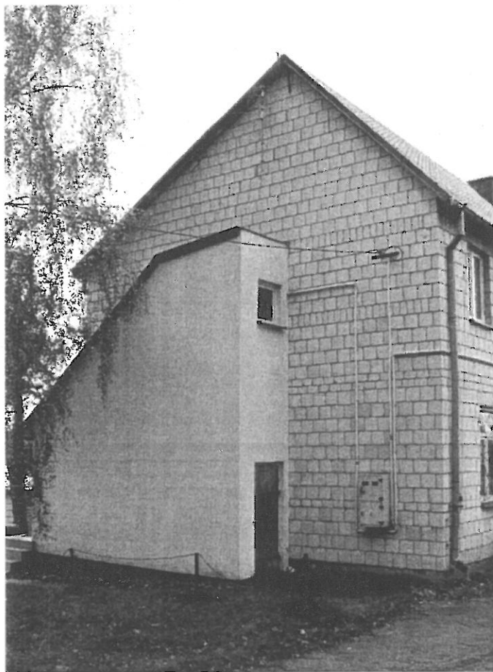
Fot.3 Elewacja wschodnia
