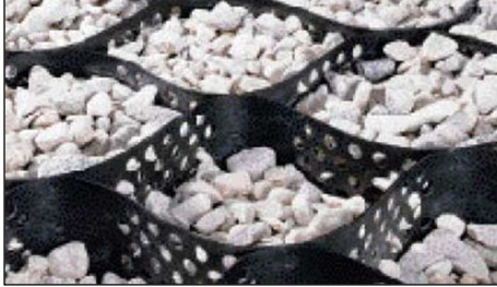
Rys. 6. Zасыpywanie kruszywem komórek geosiatki za pomocą równiarki
