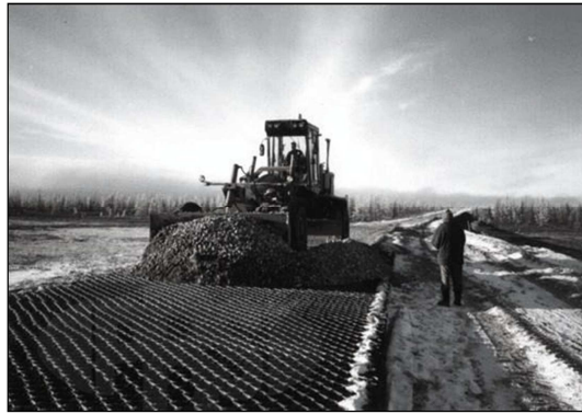
Rys. 6. Zасыpywanie kruszywem komórek geosiatki za pomocą równiarki
