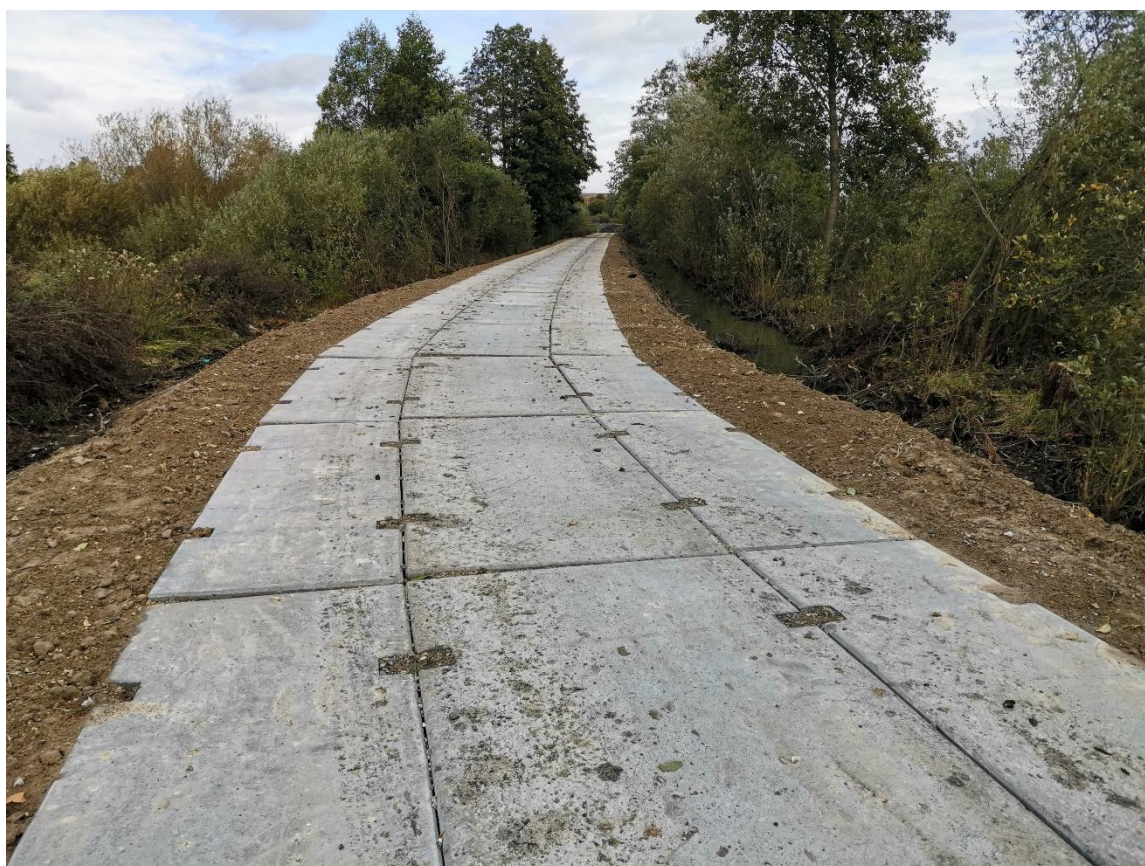
Droga do gruntów rolnych w Bzowcu
