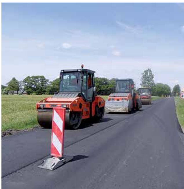
W 2014 roku zostanie przebudowanych 23 km dróg powiatowych i gminnych w Gminie Stryków
