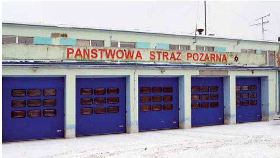
Zgierska strażnica wreszcie doczekała się modernizacji piwnic i garaży
