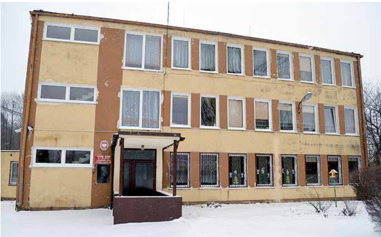
Budynek Zespołu Szkół Specjalnych w Aleksandrowie Łódzkiej czeka w tym roku termomodernizacja
