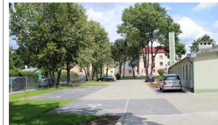
Jako ostatnie zostało zrealizowane zadanie polegające na budowie nowego ogrodzenia z bramami wjazdowymi oraz utwardzeniu terenu kostką brukową wraz z wydzieleniem miejsc parkingowych dla osób niepełnosprawnych
