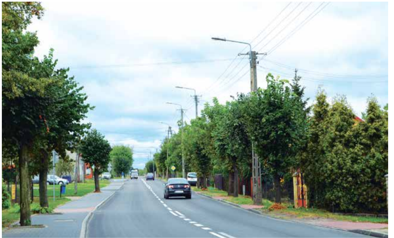
Tak prezentuje się teraz ul. Konstytucji 3 Maja w Ozorkowie, na której wykonano nową nakładkę asfaltową i wybudowano chodniki
