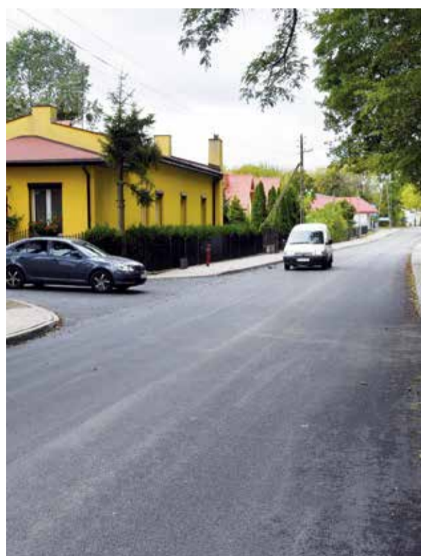
Znaczna część dróg przebudowywanych w gminie Stryków jest już skończona – tutaj droga w miejscowości Lipka
