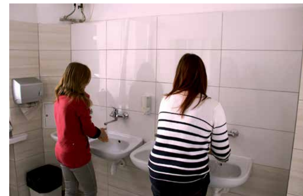
Od 1 września z nowych łazienek mogą korzystać uczennice Zespołu Szkół Ogólnokształcących w Zgierzu. Dodatkowo w ramach remontu wymieniono m.in. oświetlenie oraz naprawiono nawierzchnię boiska szkolnego
