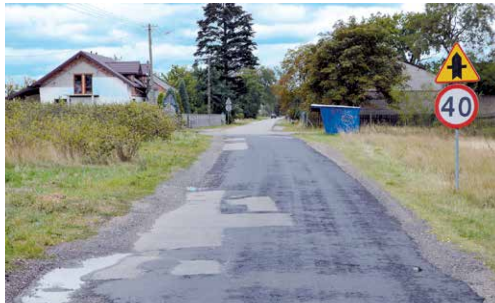
Droga relacji Bratoszewice - Domaradzyn - Popów zostanie przebudowana jeszcze w tym roku. Drogowcy położą tam dwie warstwy nawierzchni i wykonają pobocza
