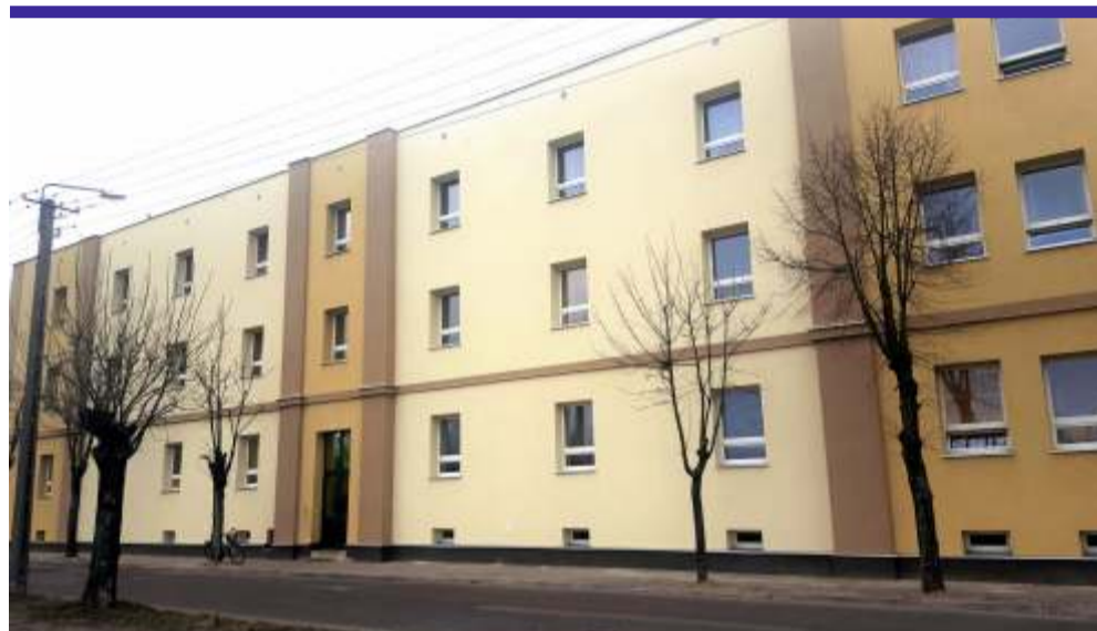
Sprzyjająca aura pozwoliła na ukończenie termomodernizacji Domu Pomocy Społecznej w Ozorkowie
