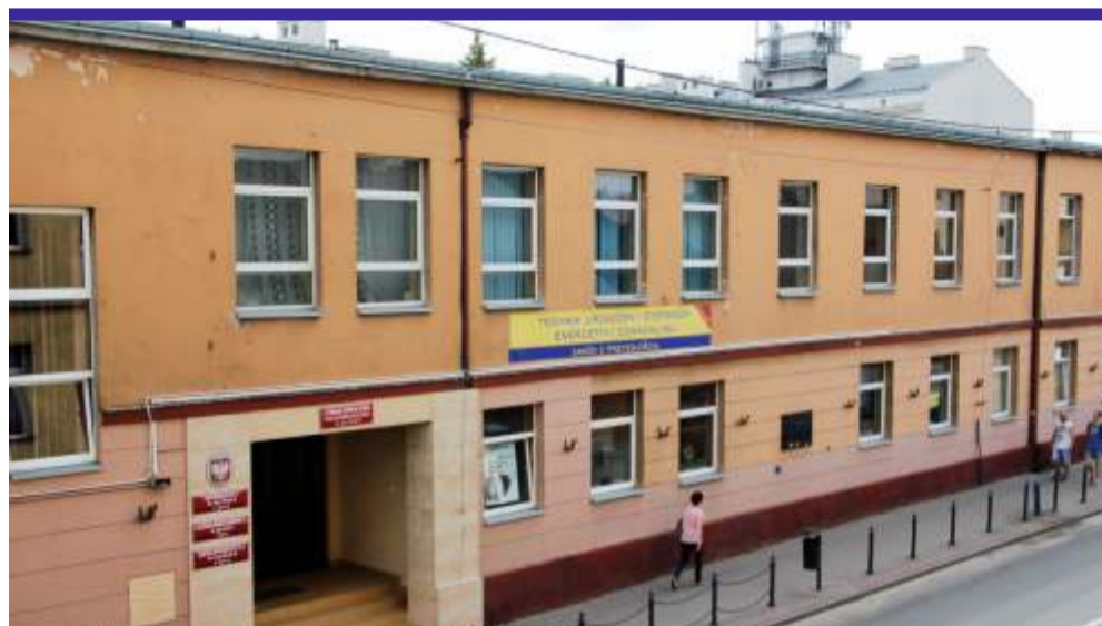
W tym roku ruszą prace związane z termomodernizacją budynków użyteczności publicznej powiatu zgierskiego, realizowane w ramach dwuczęściowego projektu, za ponad 9 mln. zł, m. in. w Zgierskim Zespole Szkół Ponadgimnazjalnych im. Jana Pawła II
