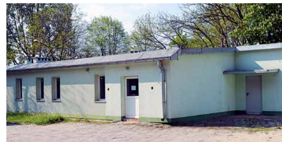
Pod koniec 2012 roku zakończył się remont poradni, teraz przyszedł czas na dawny budynek administracyjno – gospodarczy, w którym mają mieścić się nowe oddziały szpitalne
