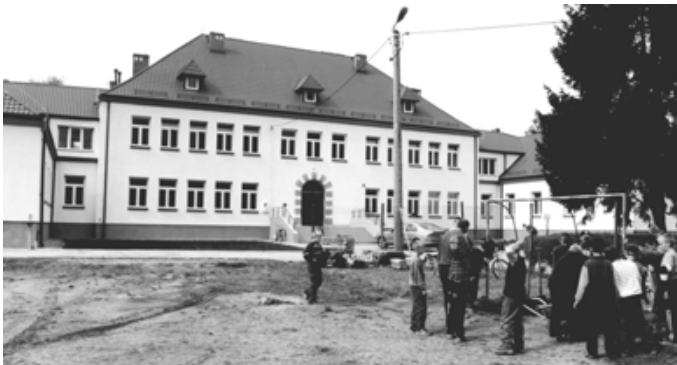
Budynek szkoły po remoncie. Fot. R. Stojek.
