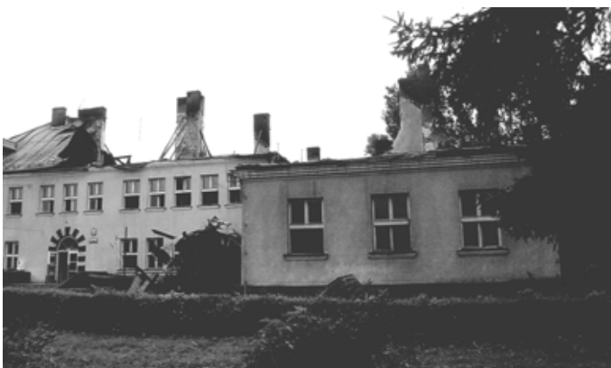
Budynek szkoły zniszczony pożarem. Fot. R. Stojek.
