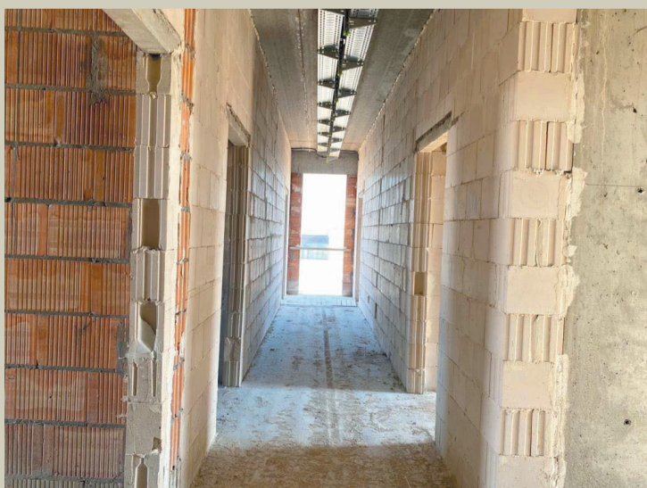
Montaż stolarki drzwiowej i okiennej
