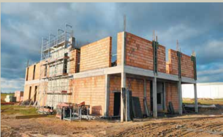
Roboty żelbetowe i murowe związane z konstrukcją parteru oraz piętra budynku
