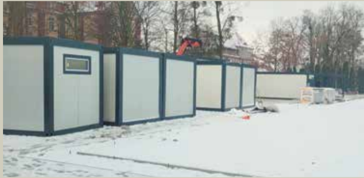
Dostawa i montaż kontenerów
