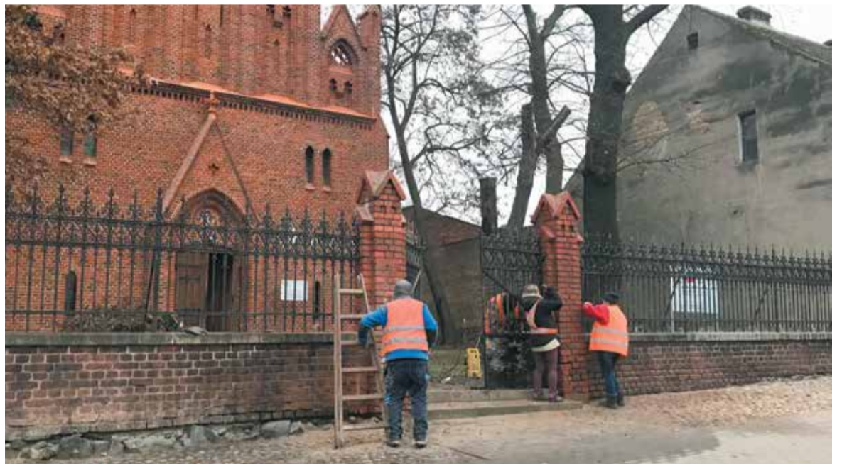
Wejście na teren obiektu przechodzi lifting
