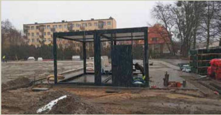
Montaż kontenerów oraz nowego ogrodzenia
