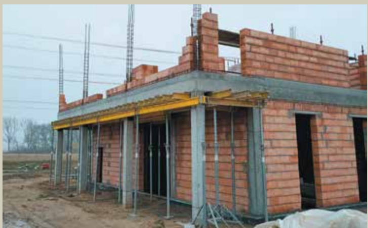
Wznoszenie piętra budynku
