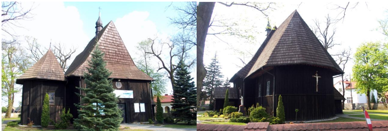
Zdjęcia nr 1, 2. Kościół filialny pw. Świętej Trójcy, Kaszewice
