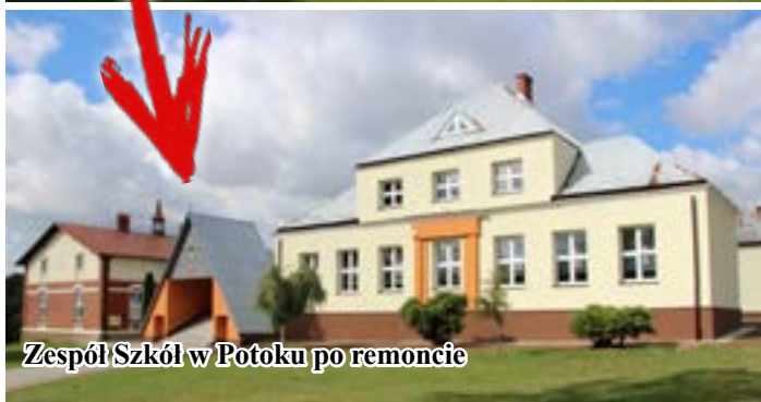
Zespół Szkół w Potoku przed remontem
