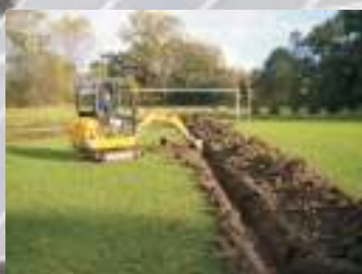
Remont stadionu w Potoku
