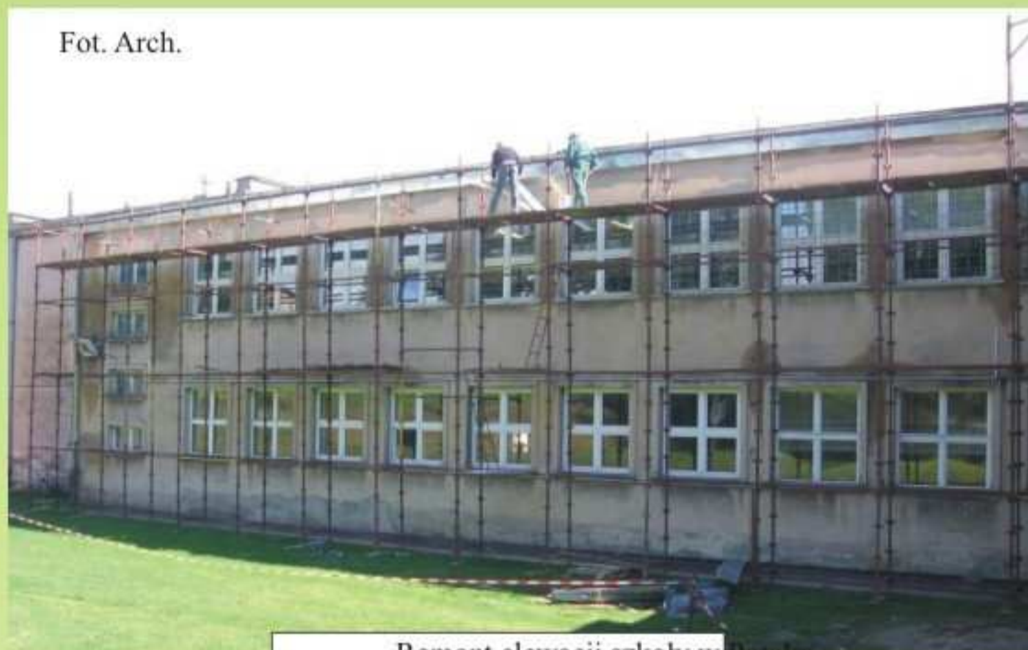
Remont elewacji szkoły w Potoku
