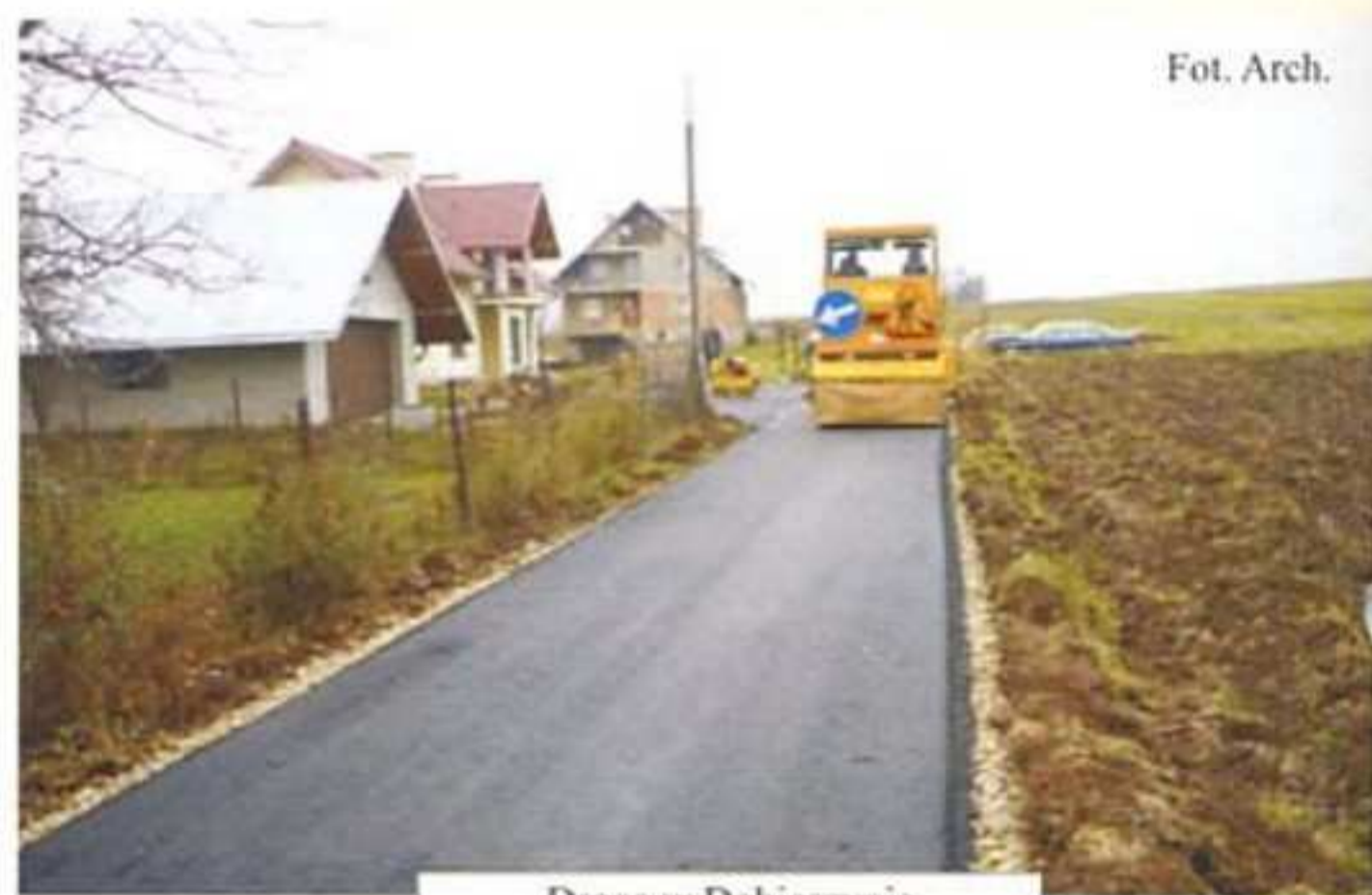
Droga w Dobieszynie
