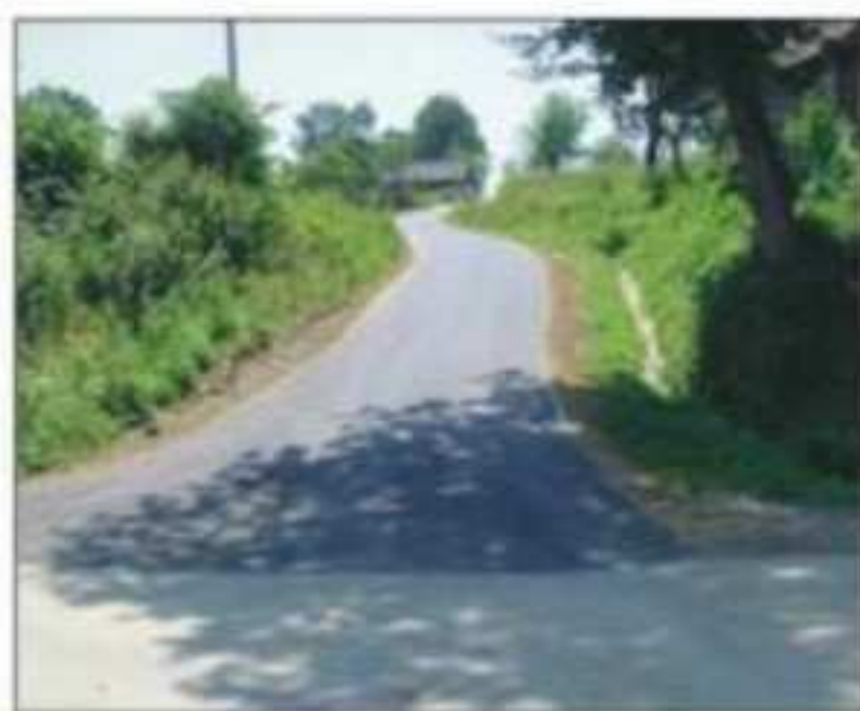
Remont drogi Podniebyle przez wieś, nawierzchnia bitumiczna, dł. 145 mb, koszt 29 517,90 zł.
