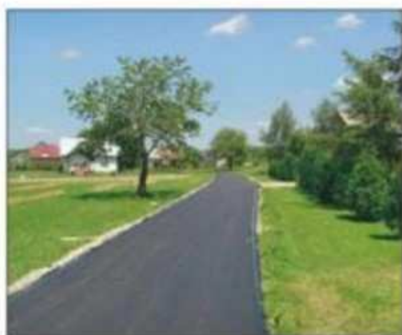
Przebudowa drogi w Jaszczwi, nawierzchnia bitumiczna, dł.701 mb, koszt 105 239,48 zł
