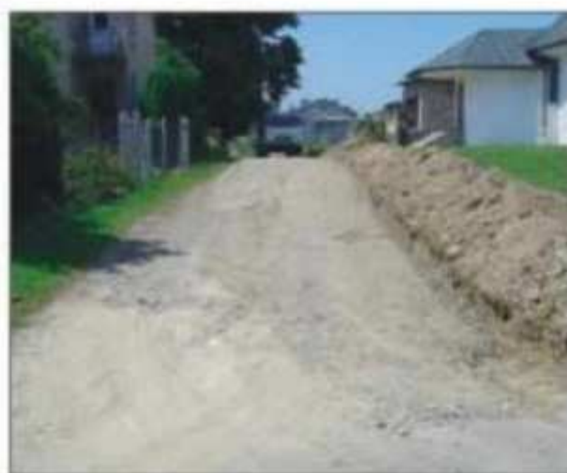
Remont drogi w Potoku koło Kościoła na długości 218 mb, koszt 65 664,41 zł.
