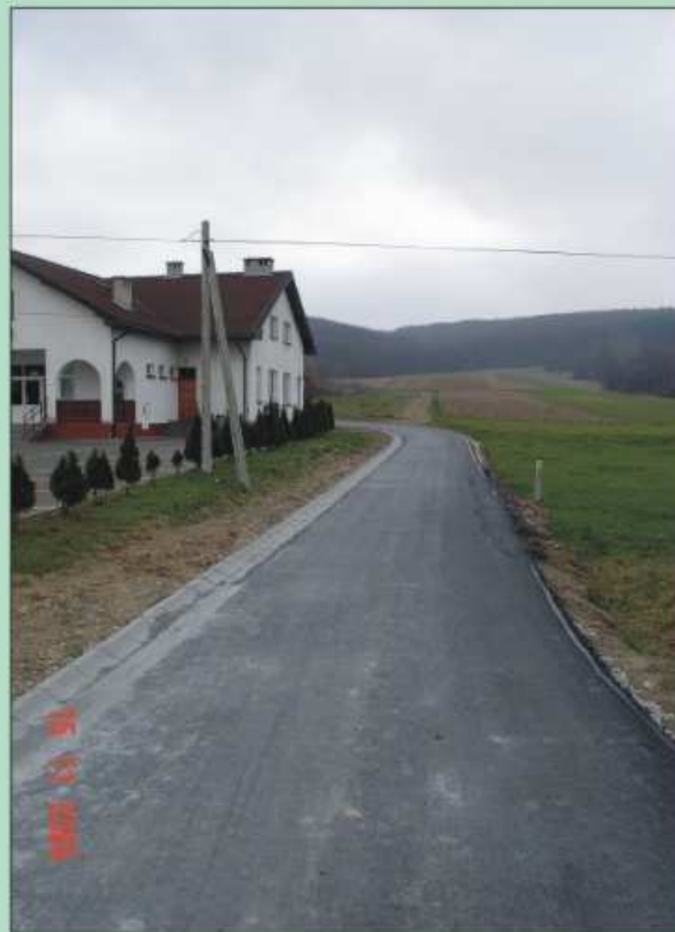
Remont drogi w Długiem
