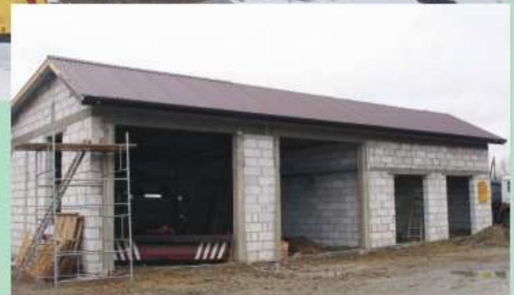
Budynek garażowo-magazynowy przy bazie JPGKiM w trakcie budowy
