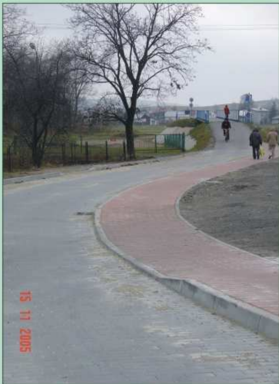
Remont drogi na kładkę Jedlicze-Borek
