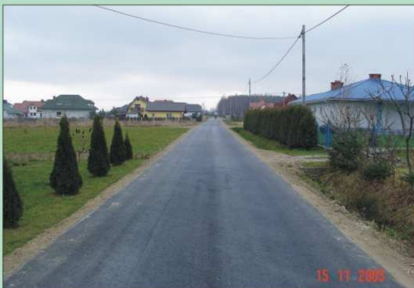
Remont drogi Dobieszyn Pasze
