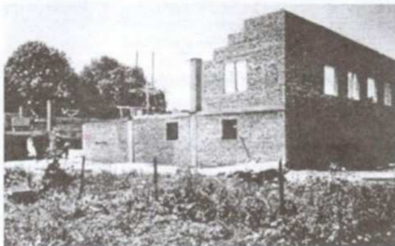
Budowa hali sportowej - 10.06.2000r.
