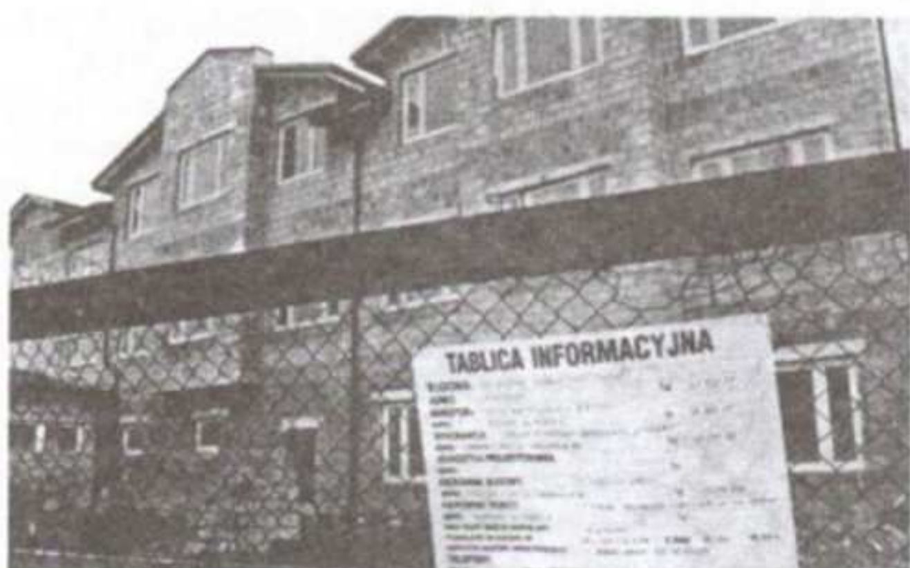
Budowa szkoły w Moderówce
