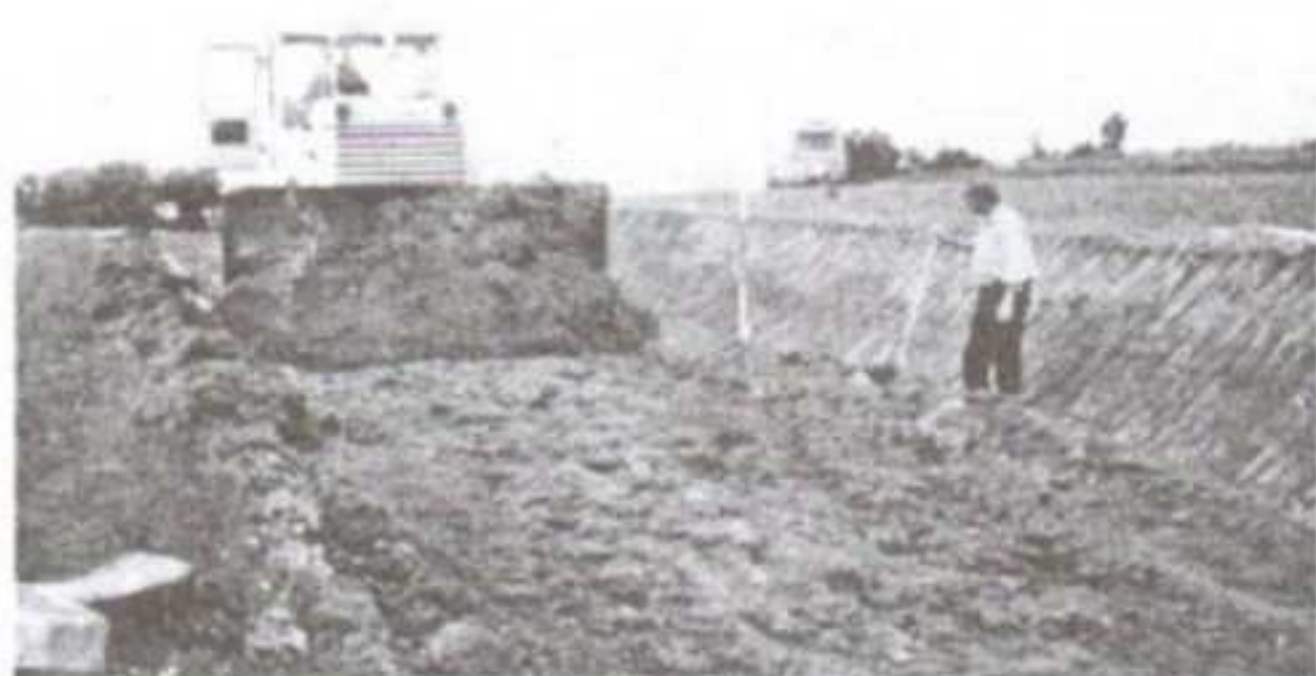
Budowa drogi rolniczej w Podniebylu
