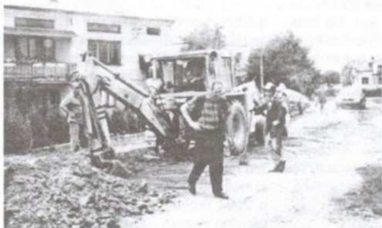
Budowa kanalizacji sanitarnej przy ulicy Słowackiego w Jedliczu
