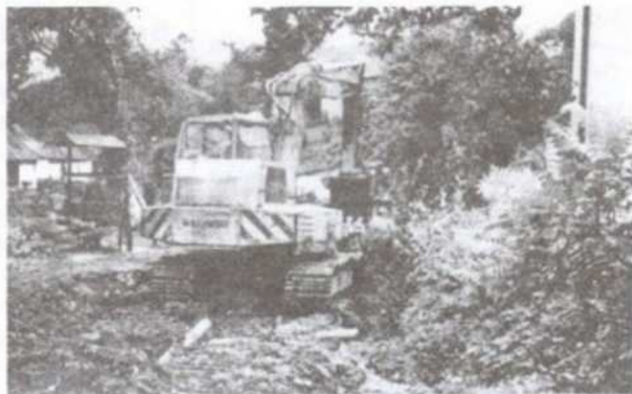
Budowa kanalizacji sanitarnej w Potoku
