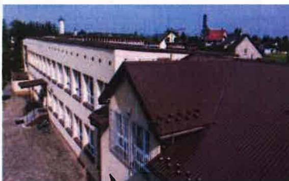
REMONT DACHU NA SZKOLE W ŁĄCZANACH
