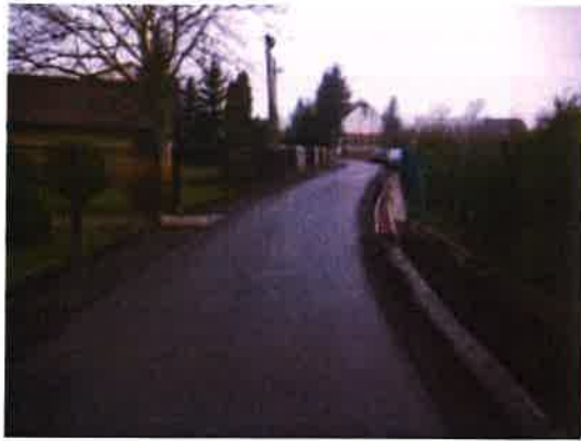
REMONT DROGI W CHRZĄSTOWICACH
