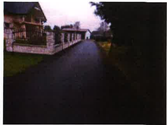
REMONT DROGI ŁĄCZANY UL. JAŚMINOWA
