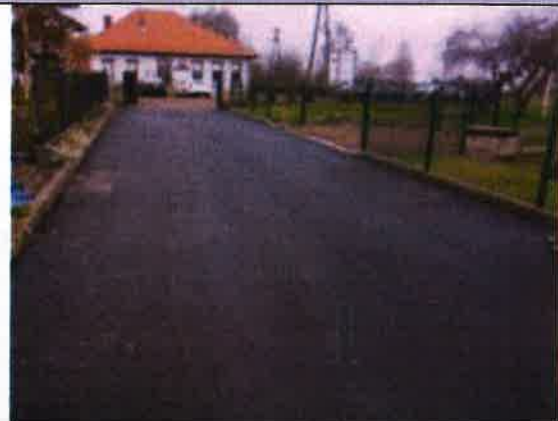
REMONT DROGI WEWNĘTRZNEJ ŁĄCZANY DO DOMU SENIORA
