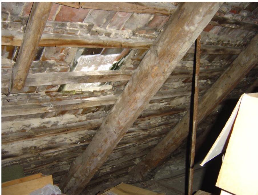
Fot. 5 Dach świetlicy i biblioteki
