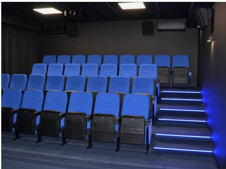
Rys. 51: Gotowy podest z fotelami. Widoczne oświetlenie krawędzi stopni.
