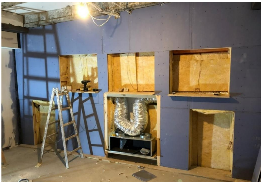
Rys. 19: Przegroda akustyczna z zainstalowaną trójwarstwową płytą akustyczną (płyta MFP obustronnie pokryta akustyczną płytą G-K). W otworach na głośniki widoczne wypełnienie wełną mineralną, która nie będzie zasłaniana płytą MFP.
