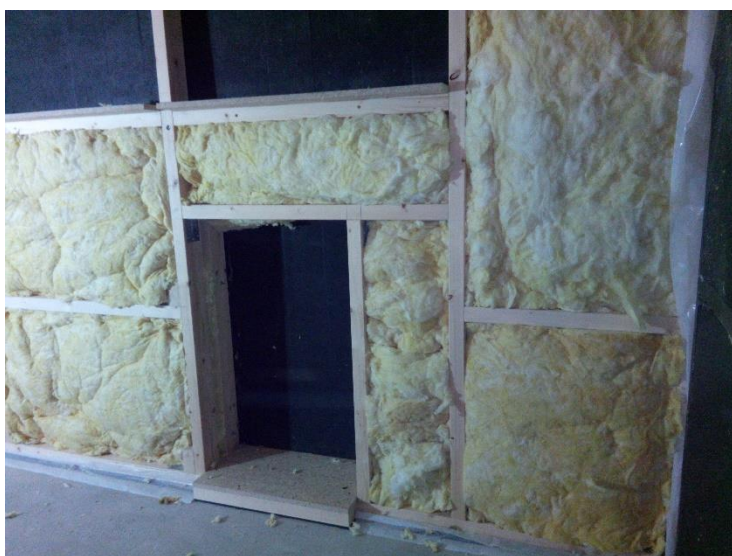
Rys. 35: W otworach na głośniki widać warstwę szklonej wełny 50 mm.
