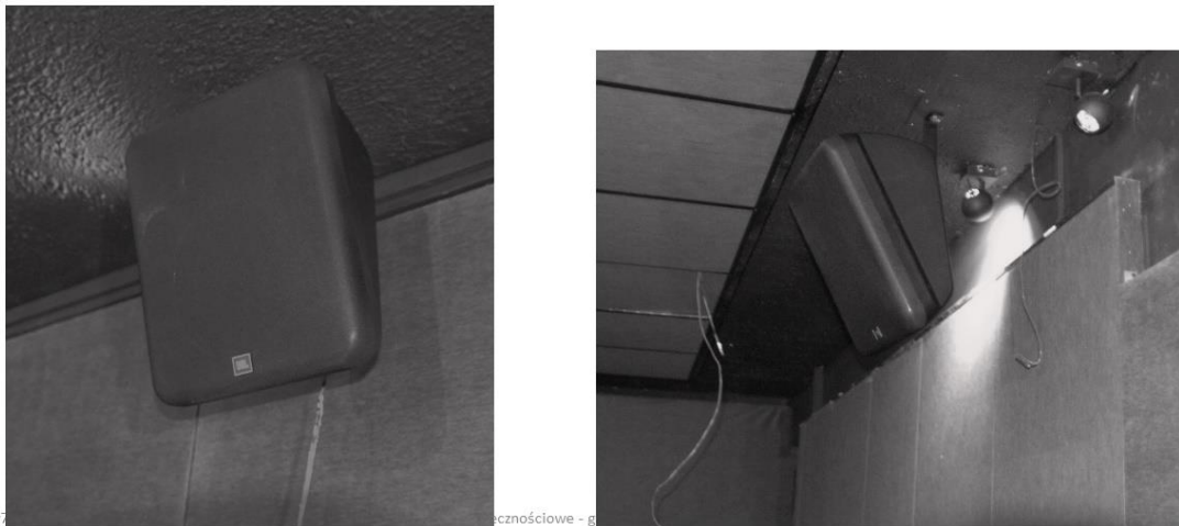
Rys. 72: Kolumny efektowe JBL 8320 zainstalowane pod sufitem.
