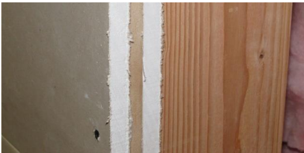
Rys. 30: Fragment trójwarstwowej płyty akustycznej przy otworze na głośnik. Brzeg płyty nie jest jeszcze wykończony.
