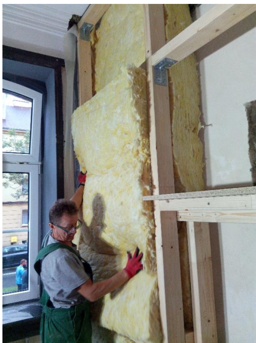
Rys. 34: Wypełnianie przestrzeni stelaża wełną mineralną o niskiej gęstości.
