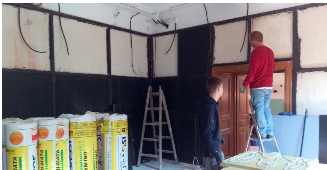
Rys. 6: Stelaż drewniany do napinania tkaniny oraz mocowania okładziny dźwiękochłonnej na ścianach. Stosowanie listew poziomych przy każdym arkuszu nie jest konieczne – wystarczą te na górze i na dole.
