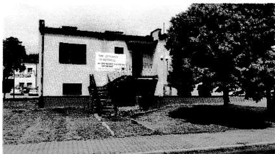
Fot.1 Wymagający remontu budynek po byłej Telekomunikacji Polskiej
