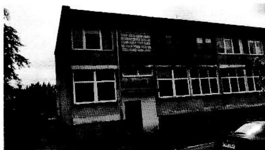
Fot.2 Wymagający termomodernizacji budynek Ośrodka Zdrowia
