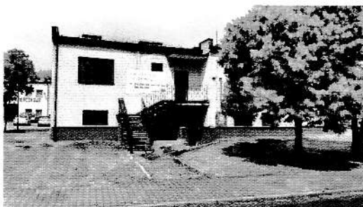
Fot.1 Wymagający remontu budynek po byłej Telekomunikacji Polskiej
