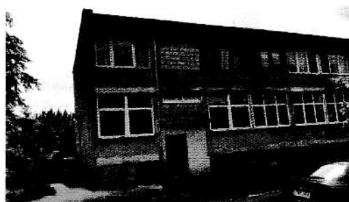
Fot.2 Wymagający termomodernizacji budynek Ośrodka Zdrowia
